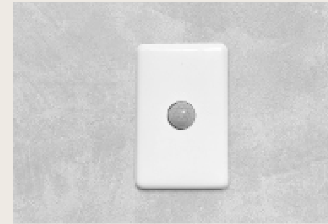
Sensores de presença nas áreas comuns
