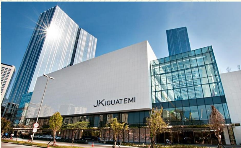
JK IGUATEMI 1,6 KM DO EMPREENDIMENTO
